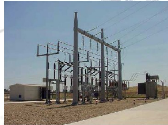
Módulo compacto 72 kV. Pos línea
