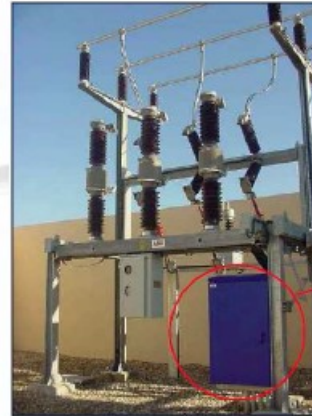
Módulo compacto 72 kV. Pos línea
